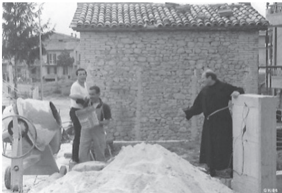
Figura 2. Padre Mario Petrella e Gianfranco Rossi impegnati nei lavori di ristrutturazione della chiesetta (foto scattata nel giugno 1986, fonte: Giuseppe Rinaldi).
